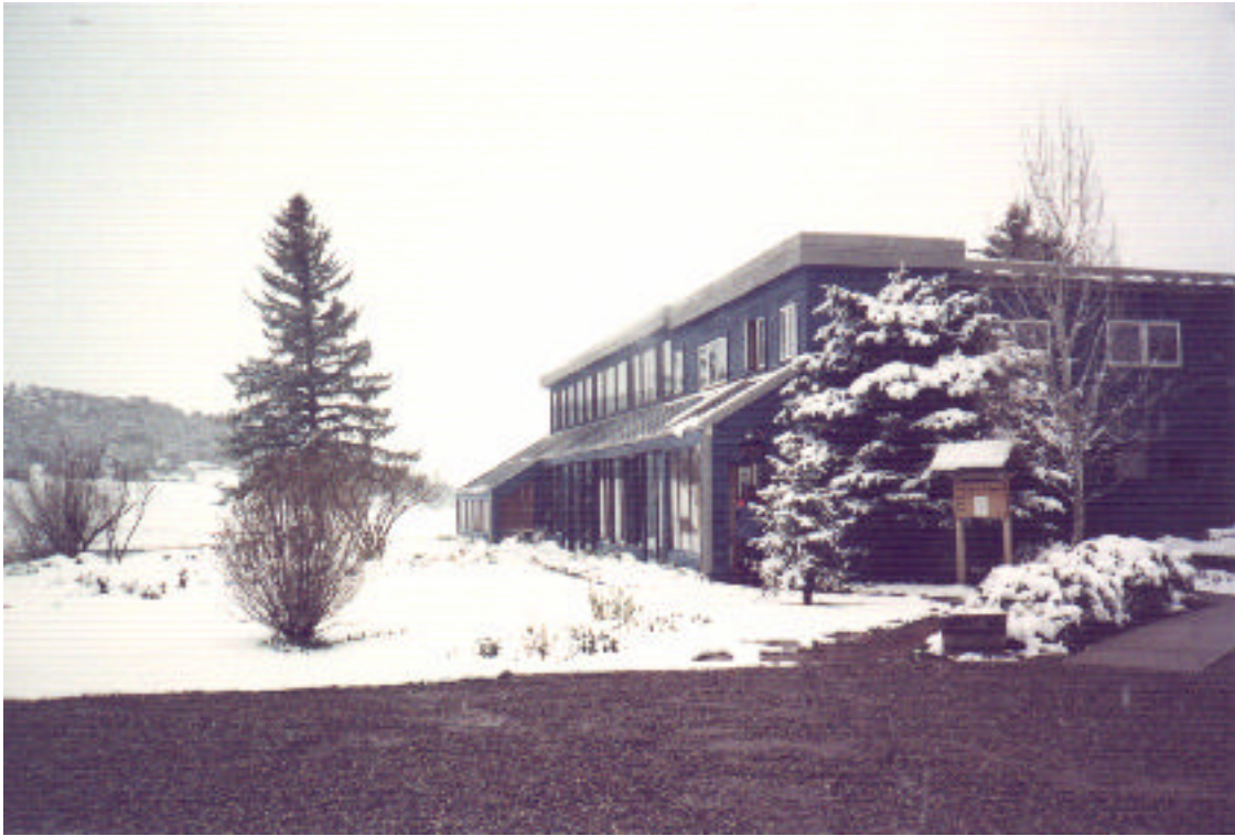
Vista exterior del edificio de Rocky Mountain Institute, en Colorado USA, el cual tiene un diseño bioclimático y emplea tecnología solar.
