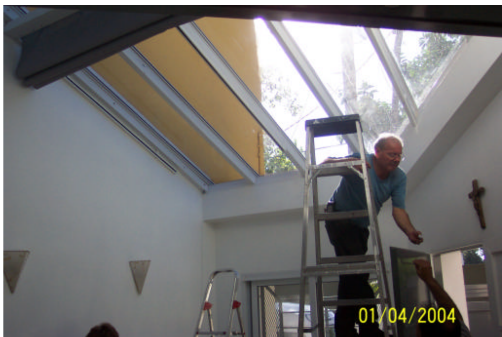
Instalación de cortinas para protección solar en invernadero.
